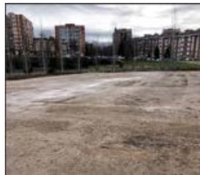
ADECUACIÓN DEL TERRENO PARA CONSTRUCCIÓN DE CANCHA POLIDEPORTIVA MUNICIPAL
