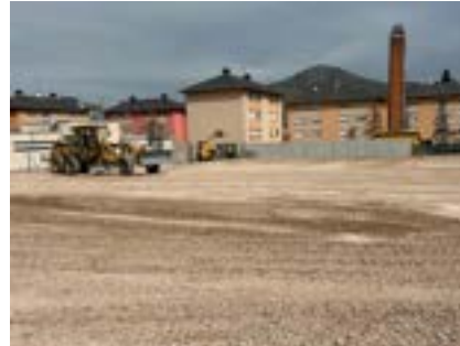
RELLENO Y NIVELACIÓN PARA PAVIMENTACIÓN
